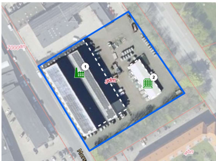
Figur 4.4.7: Satellitkort over KVK Hydra Klov A/S og afgrænsning af grund fra BBR
